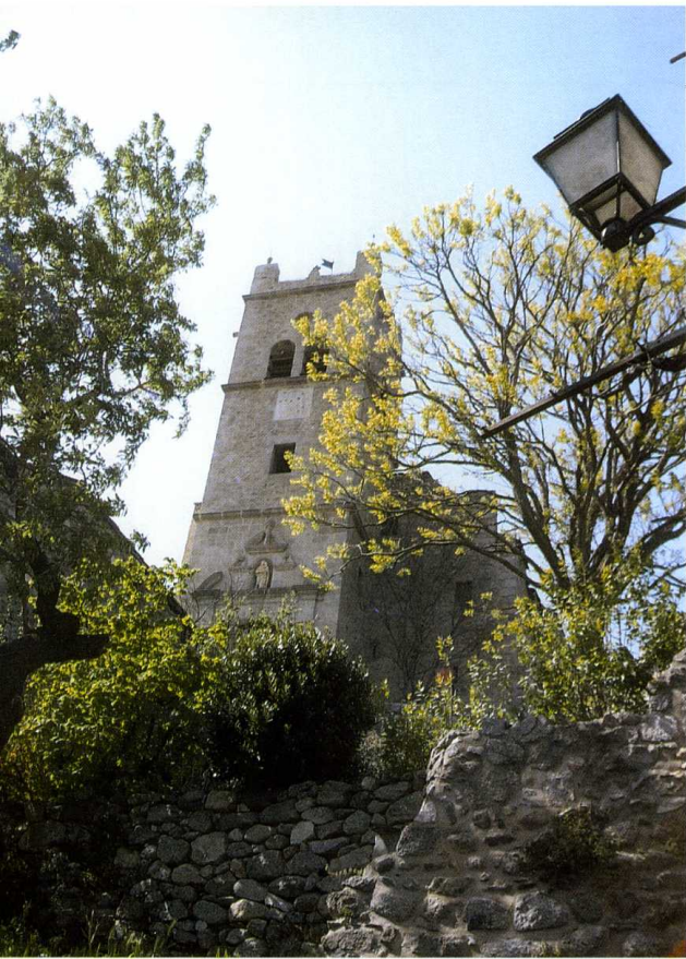
Eus (Pyrénées-Orientales) Église Saint-Vincent d'En-Haut 3. Clocher façade occidentale 4. Élévation du mur sud et rempart
