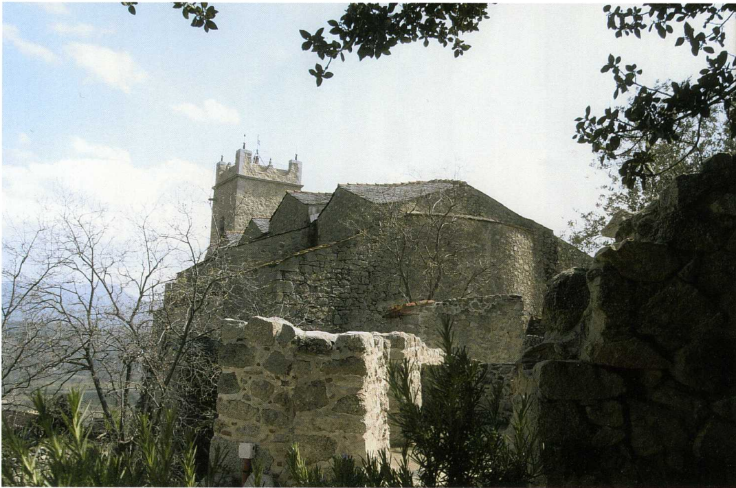
Eus (Pyrénées-Orientales) Église Saint-Vincent d'En-Haut 1. Élévation sud-est
