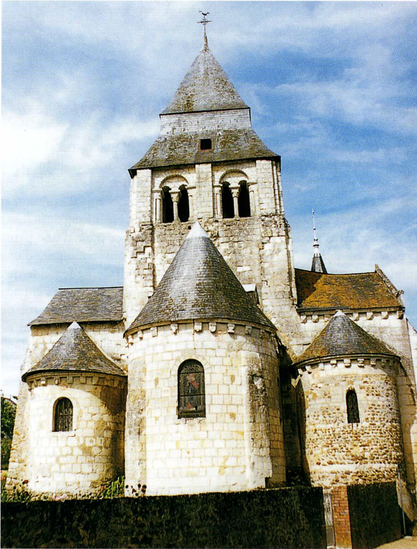
Échemiré (Maine-et-Loire) Église Saint-Martin Tour du transept et chevet
